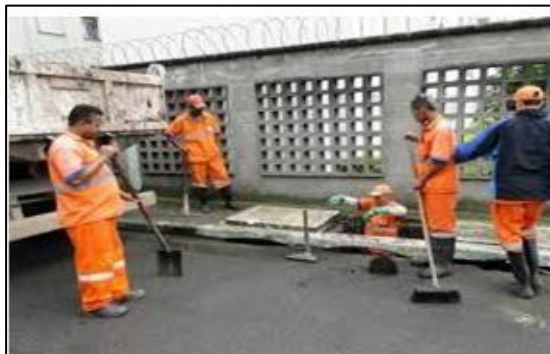
Limpeza de Boca de Lobo
